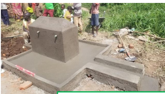
Lissage borne fontaine avant sa connexion au réseau d'alimentation
