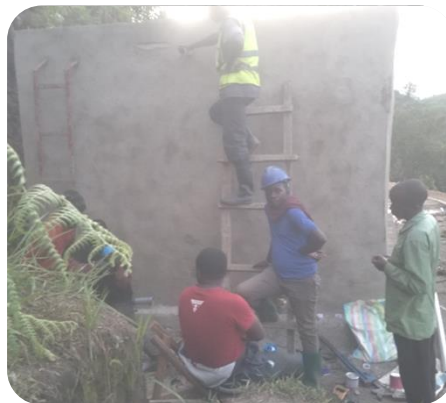
Réservoir en finition
