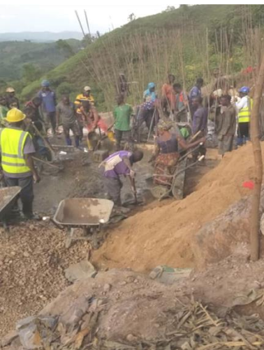
Bétonnage radié du réservoir
