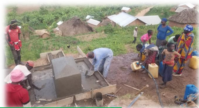
Lissage borne fontaine avant sa connexion au réseau d'alimentation
