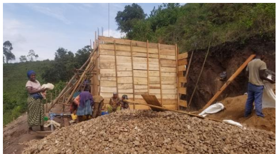
Travaux de ferrallage et coffrage du réservoir avec stakage des graviers et moellon.
