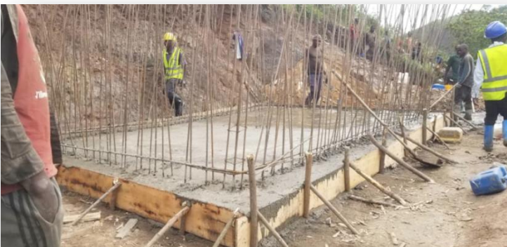
Travaux de ferrallage et coffrage du réservoir avec stakage des graviers et moellon.
