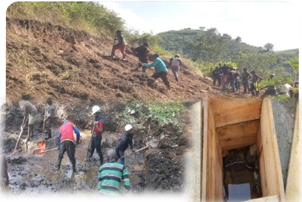
Recherche, fouille de la source et chambre de captage
